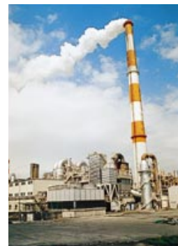
大昭和製紙・本社工場富士で昨年4月に稼働したペーパースラッジ焼却炉
