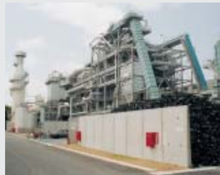
コストダウンと環境負荷低減に寄与する廃棄物発電用ボイラー(*15)：日本大昭和板紙東北株式会社
