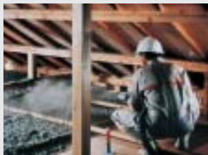
断熱材の施工現場
