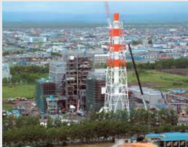
建設中の電力卸供給設備(釧路工場)
