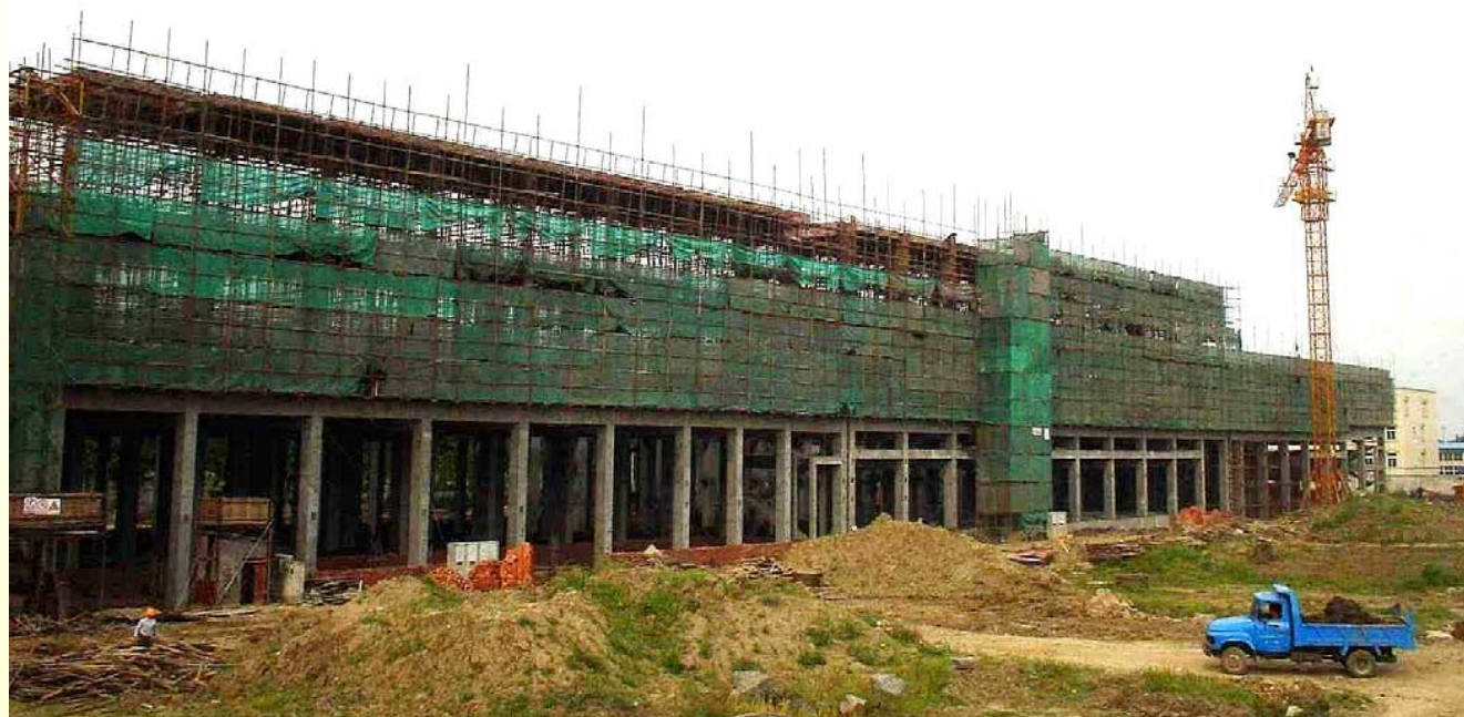
(建設が進む中国景興日紙/中芯原紙マシンの建屋 2004/5/24撮影)
