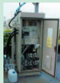
排ガス連続分析装置
