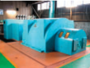
自家発電設備(タービン)
