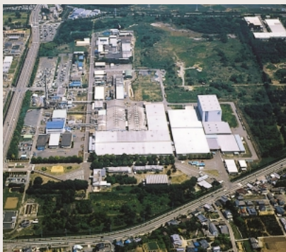
発電設備建設予定の勿来工場
