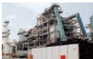
廃棄物発電用ボイラー
