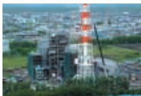
建設中の電力供給設備（釧路工場）
