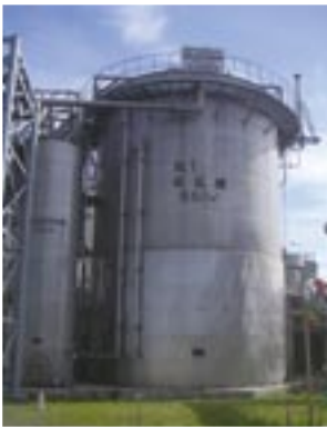
嫌気性排水処理設備(日本製紙(株)勇払工場)
