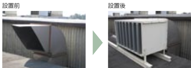
抄紙機建屋屋上排気塔へ設置した消音器(日本製紙(株)富士工場)
