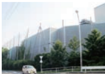
工場外周へ設置した防音壁 (日本製紙(株)石巻工場)
