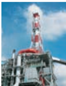
バイオマスボイラー (日本製紙(株)岩国工場)
