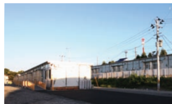
社有地に建設された仮設住宅
