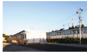
社有地に建設された仮設住宅
