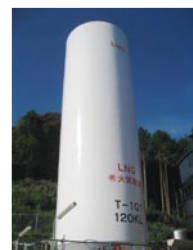
日本製紙パピリア(株)高知工場のLNGサテライト設備
