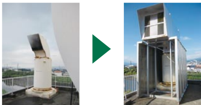
騒音対策 工事前(左)と工事後(右)(日本製紙(株)富士工場)
