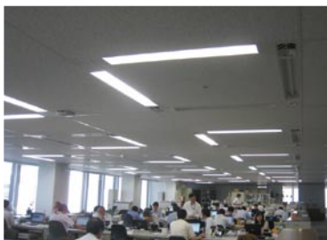
約5割の蛍光灯を間引き、ブラインドの開閉で自然光を取り入れる
