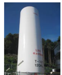
日本製紙パピリア(株)高知工場のLNGサテライト設備
