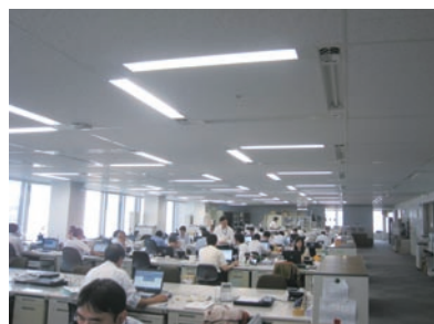
約5割の蛍光灯の間引き、ブラインドの開閉で自然光を取り入れる
