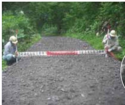
ボイラー燃焼灰を有効利用した土木資材(右写真)の林道施工への活用
