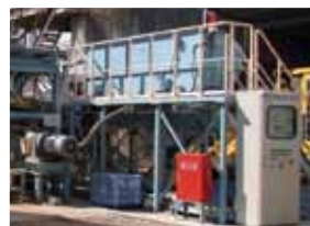
北上製紙(株)一関工場の固形燃料化設備
