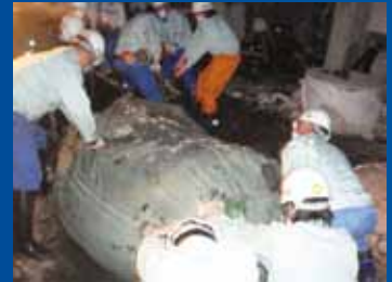
手作業による瓦礫撤去
