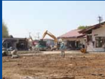
重機による瓦礫除去
