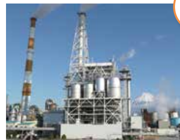
日本製紙(株)富士工場の発電設備
