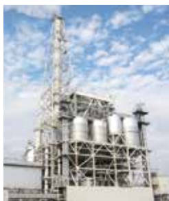
富士工場 第3号バイオマスボイラー
