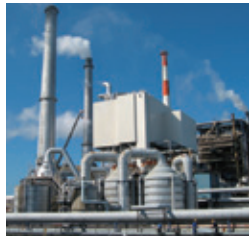
バイオマスボイラー (日本製紙(株)岩国工場)
