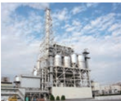
富士工場3号 バイオマスボイラー
