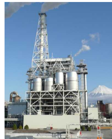
日本製紙富士工場 3号バイオマスボイラー
