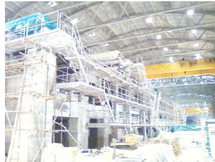
洪梅工場で建設中の白板紙抄紙機
