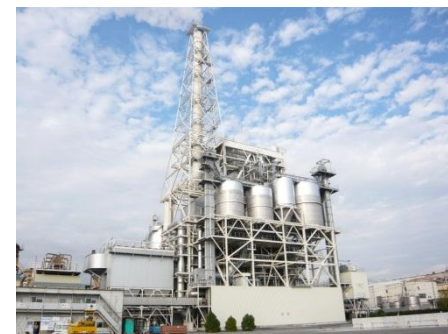
日本製紙富士工場 3号バイオマスボイラー
