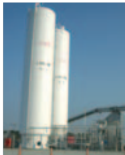
エヌ・アンド・イー(株)に完成したLNGターミナル
