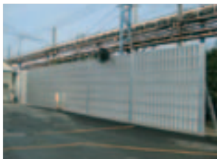
工場に設置した騒音防止設備 (防音壁)
