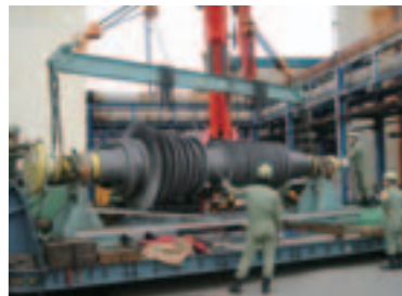
発電所タービンローターの設備点検
