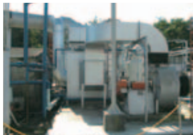
排ガス濃縮装置(日本製紙ケミカル(株)東松山事業所)
