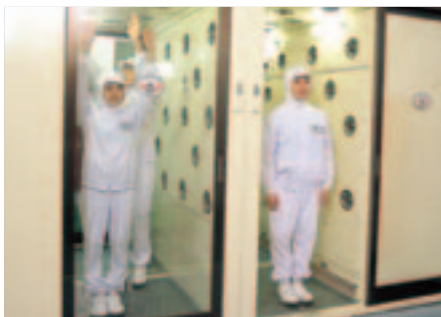
製造区域前室のエアシャワーによる付着物除去
