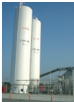
LNGサテライト設備(エヌ・アンド・イー(株))
