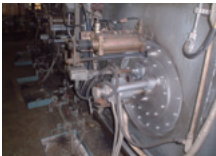
低NOxバーナーを採用したボイラー (日本製紙(株)勇払工場)
