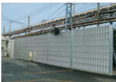
工場に設置した騒音防止設備 (防音壁)
