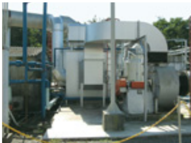
排ガス濃縮装置(日本製紙ケミカル(株)東松山事業所)
