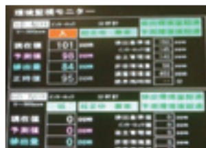
環境監視モニターの画面
