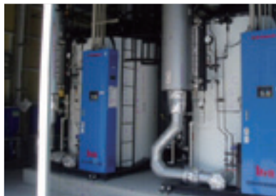
貫流式ボイラー(日本製紙パピリア(株)吹田工場)
