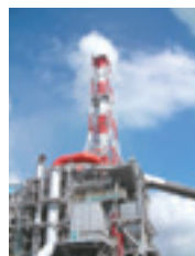
バイオマスボイラー (岩国工場)
