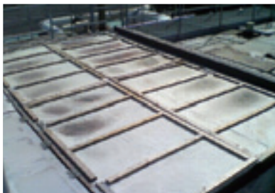
臭気封じ込めを施したアクチスクリーン開口部
