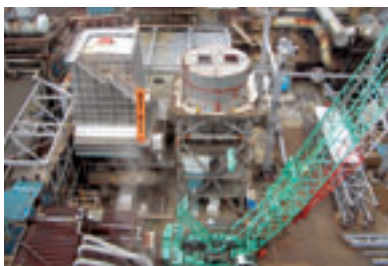
建設中のバイオマスボイラー(日本製紙(株) 石巻工場)
