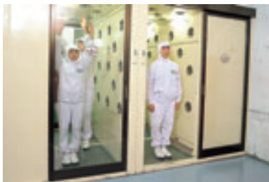
製造区域前室のエアシャワーによる付着物除去
