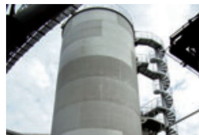
嫌気性排水処理設備(日本製紙(株) 岩国工場)
