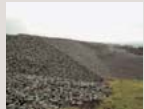
応急処置後の状態
