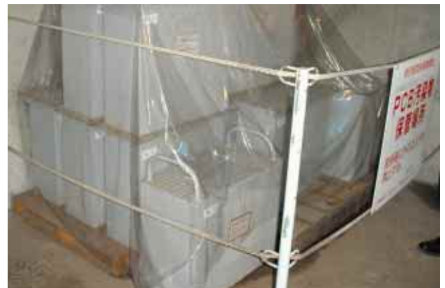
含PCB電気機器の保管箱(釧路)
