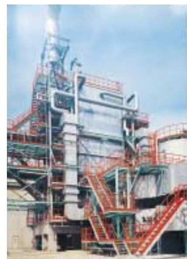
低ノックスボイラー(芸防)
