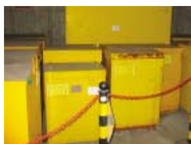
PCB電気機器保管状況(吉永)
