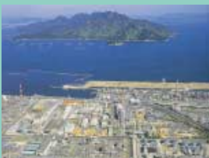
本社 / 芸防工場
