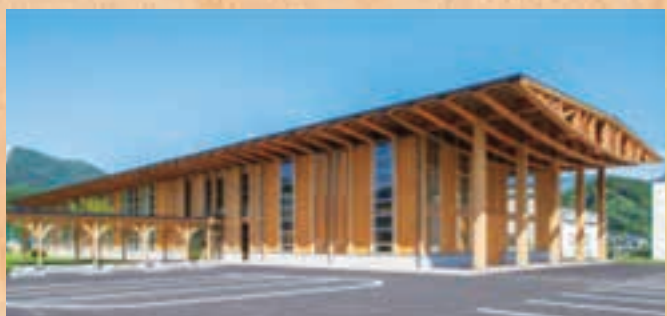
公共の木造建築物の例: 岩手県気仙郡住田町の木造庁舎 2014年9月に完成
