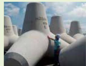
CfFA®を配合した40トン級消波ブロック
