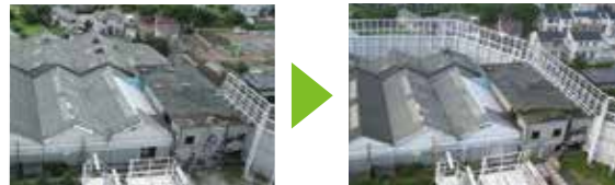
騒音対策防音壁の設置 工事前(左)と工事後(右)(日本製紙(株)富士工場)
