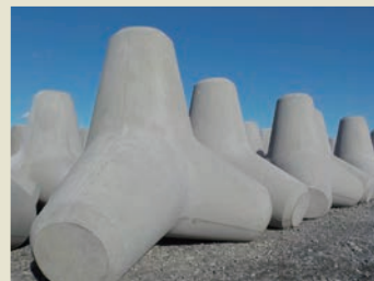
日本製紙(株)石巻工場放流口の消波ブロック
