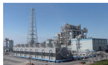
石巻雲雀野バイオマス発電所
