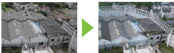
騒音対策防音壁の設置 工事前(左)と工事後(右)(日本製紙(株)富士工場)
