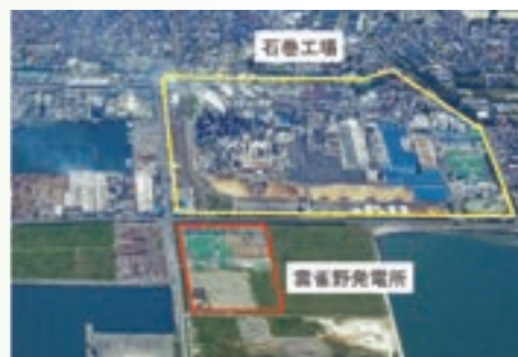
日本製紙石巻工場と雲雀野用地(建設予定地) ※ 宮城県発行のパンフレット「Ports of MIYAGI 宮城の港湾」掲載の写真を基に日本製紙にて一部編集しています。
