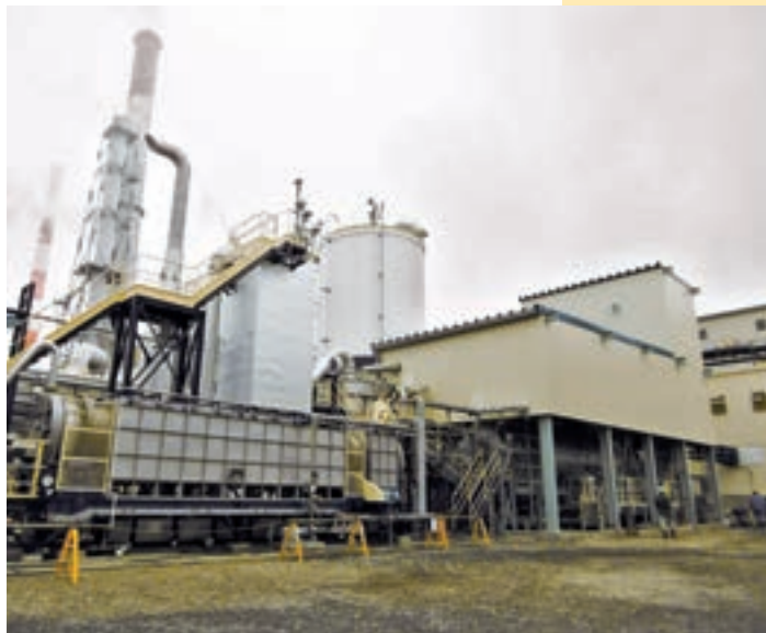
完成した「CfFA ® 」製造設備 (全景)
