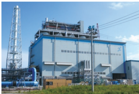
来春稼働に向けた準備が進む石炭・バイオマス混焼火力発電設備
