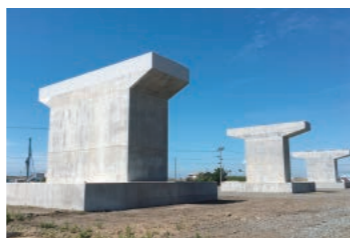
CfFAを使った橋脚 The bridge pier using CfFA
