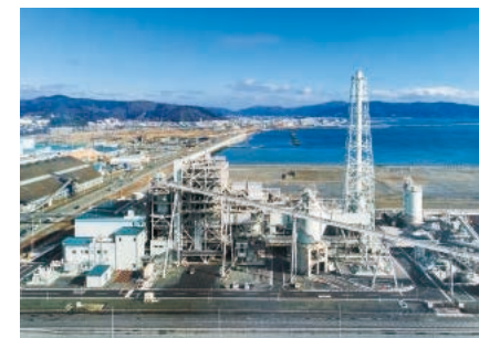
石巻雲雀野発電所 所在地: 宮城県石巻市 発電規模: 149,000kW 燃料: バイオマス燃料を最大30%まで混焼可能 Ishinomaki Hibarino power plant Location: Ishinomaki City, Miyagi Power generation output: 149,000kW Fuel: Biomass co-firing ratio up to 30%
