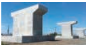
CfFAを使った橋脚 The bridge pier using CfFA
