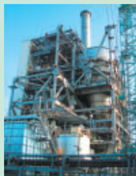
現在建設中の石巻工場のバイオマスボイラー
