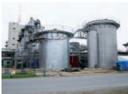
建設中の実証プラント
