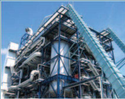
バイオマスボイラー (日本製紙株式会社勿来工場)
