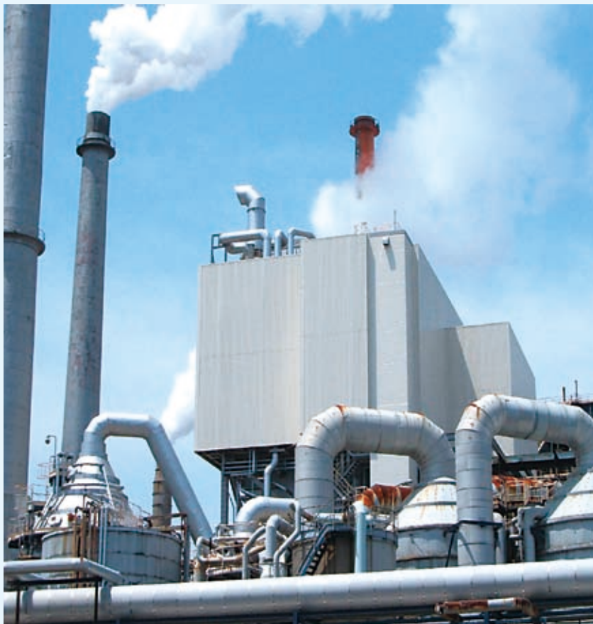
日本製紙株式会社石巻工場バイオマスボイラー
