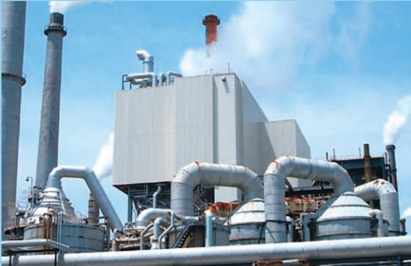
新エネルギーボイラー
