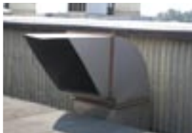
抄紙機建屋屋上排気塔へ設置した消音器(日本製紙(株)富士工場)
