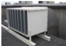
抄紙機建屋屋上排気塔へ設置した消音器(日本製紙(株)富士工場)
