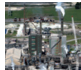
2009年に改修を行った エネルギープラント
