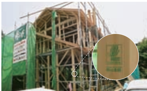
北山社有林で生産された木材を使用した「SGEC森林認証の家」
