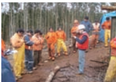
作業現場での安全講習会
