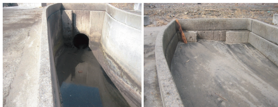
左/二ノ倉排水処理場、3月18日視察時は排水口が見える。中/3月20日大潮により排水口が砂で完全に埋没。右/重機を現場に入れることが出来ないことから、スコップ隊を編成。昼夜にわたって砂をかき出す。
