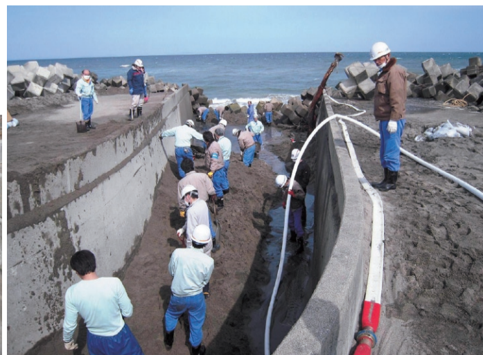
左/二ノ倉排水処理場、3月18日視察時は排水口が見える。中/3月20日大潮により排水口が砂で完全に埋没。右/重機を現場に入れることが出来ないことから、スコップ隊を編成。昼夜にわたって砂をかき出す。
