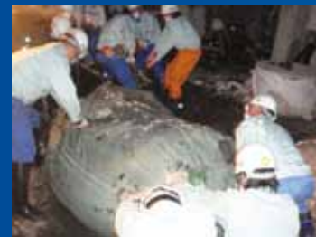
手作業による瓦礫撤去
