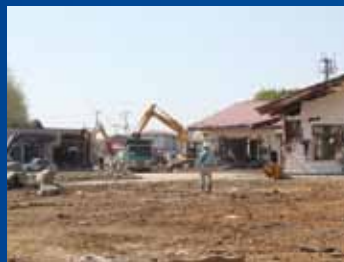
重機による瓦礫除去
