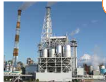
日本製紙(株)富士工場の発電設備
