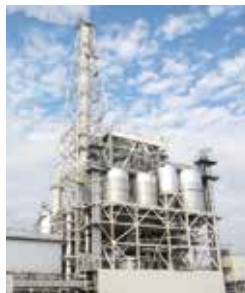
富士工場 第3号バイオマスボイラー
