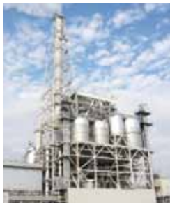
富士工場 第3号バイオマスボイラー
