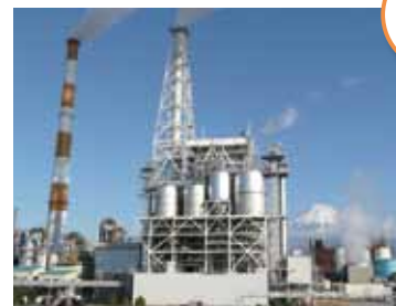
日本製紙(株)富士工場の発電設備
