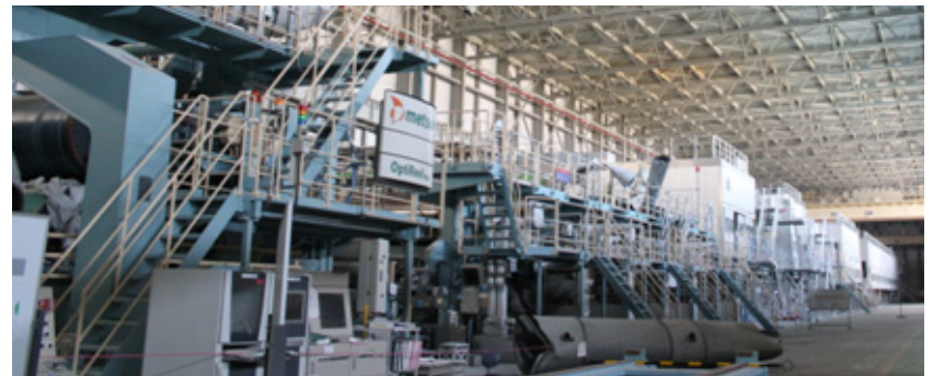
抄紙機本体(2階部分は大きな損傷なし)
