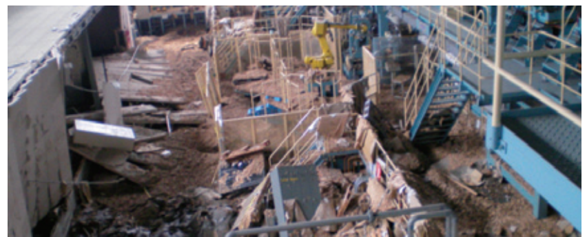
N6包装設備(1階部分は損傷激しい)
