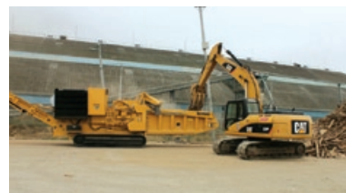
受け入れた瓦礫を破碎処理するようす
