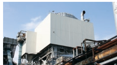
電力供給を行う石巻工場1号ボイラー
