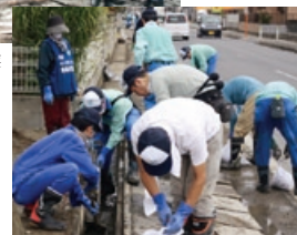
側溝の泥のかき出し作業
