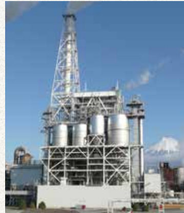
稼働中のバイオマスボイラー (日本製紙(株)富士工場第3号ボイラー)
