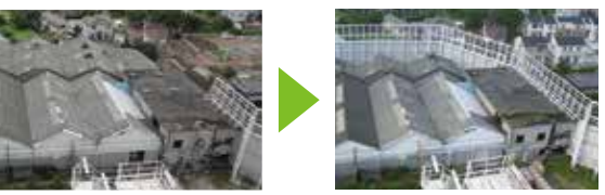
騒音対策防音壁の設置 工事前(左)と工事後(右)(日本製紙(株)吉永工場)
